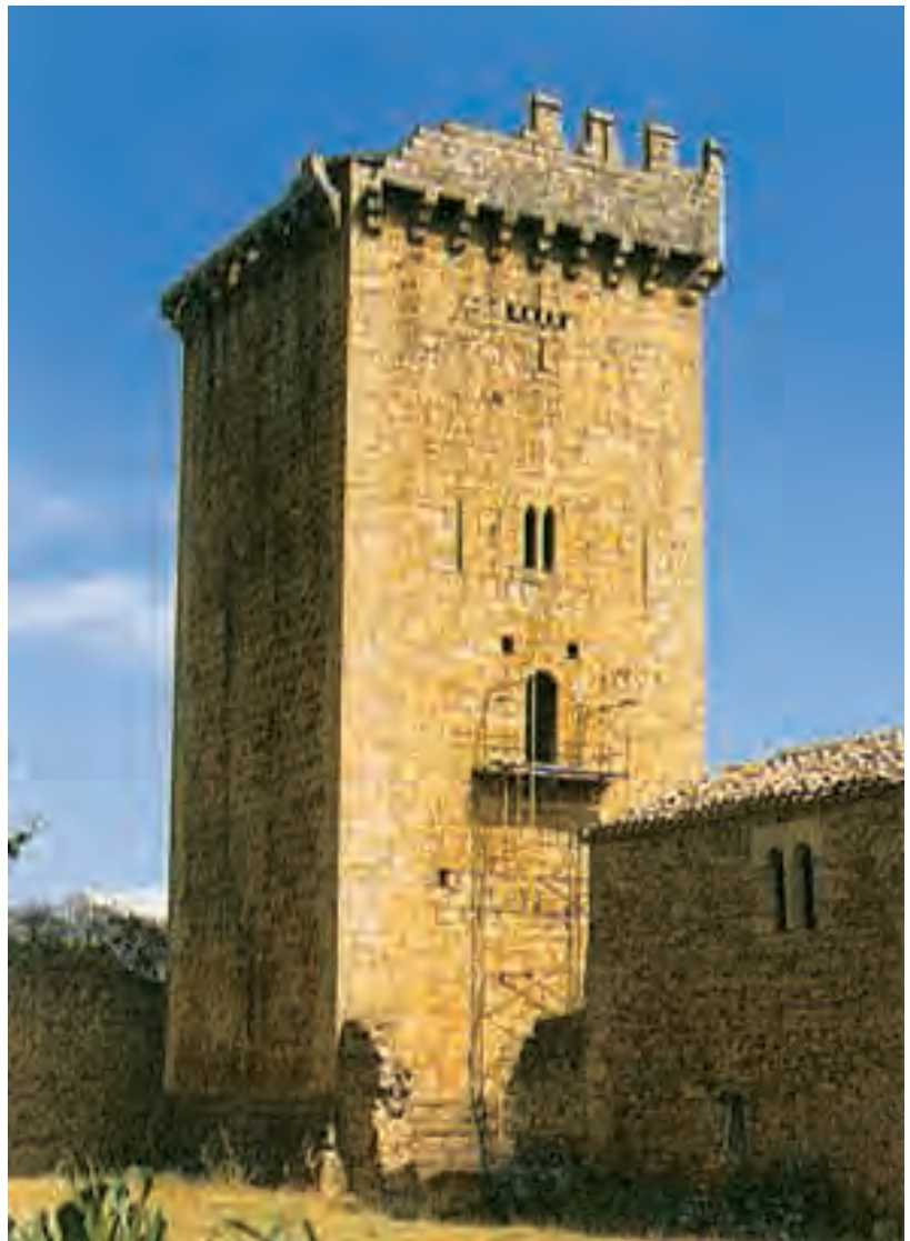
Torre del Palacio cabo de armería de los Ayanz, dentro del valle de Lónguida
